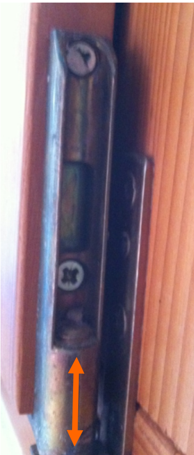
Höhenverstellung, Fenster montiert
