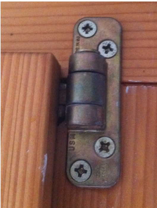
Schwenk- Kipplager oben
