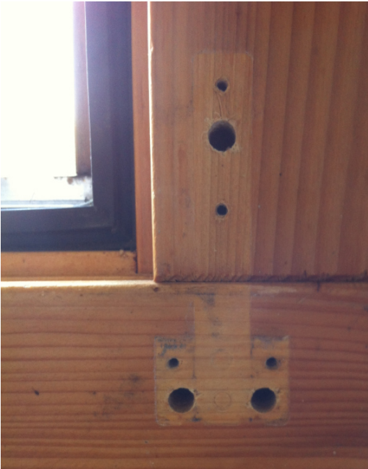
Informativ: Schwenk- Kipplager unten, demontiert
