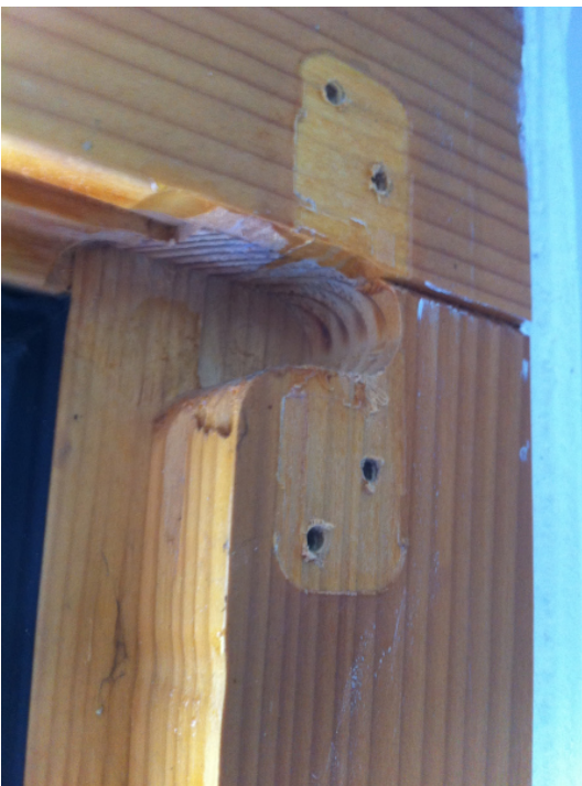
Informativ: Schwenk- Kipplager oben, demontiert
