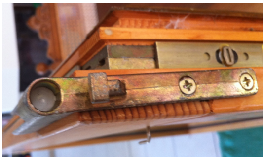
Höhenverstellung unteres Schwenk- Kipplager
