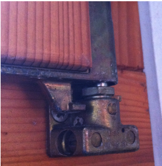
Schwenk- Kipplager unten
